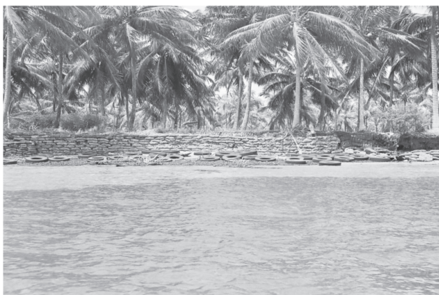
Figura 6 – Sacos de areia e mantas de pneus como estratégia para a contenção da erosão nas margens do rio São Francisco.
