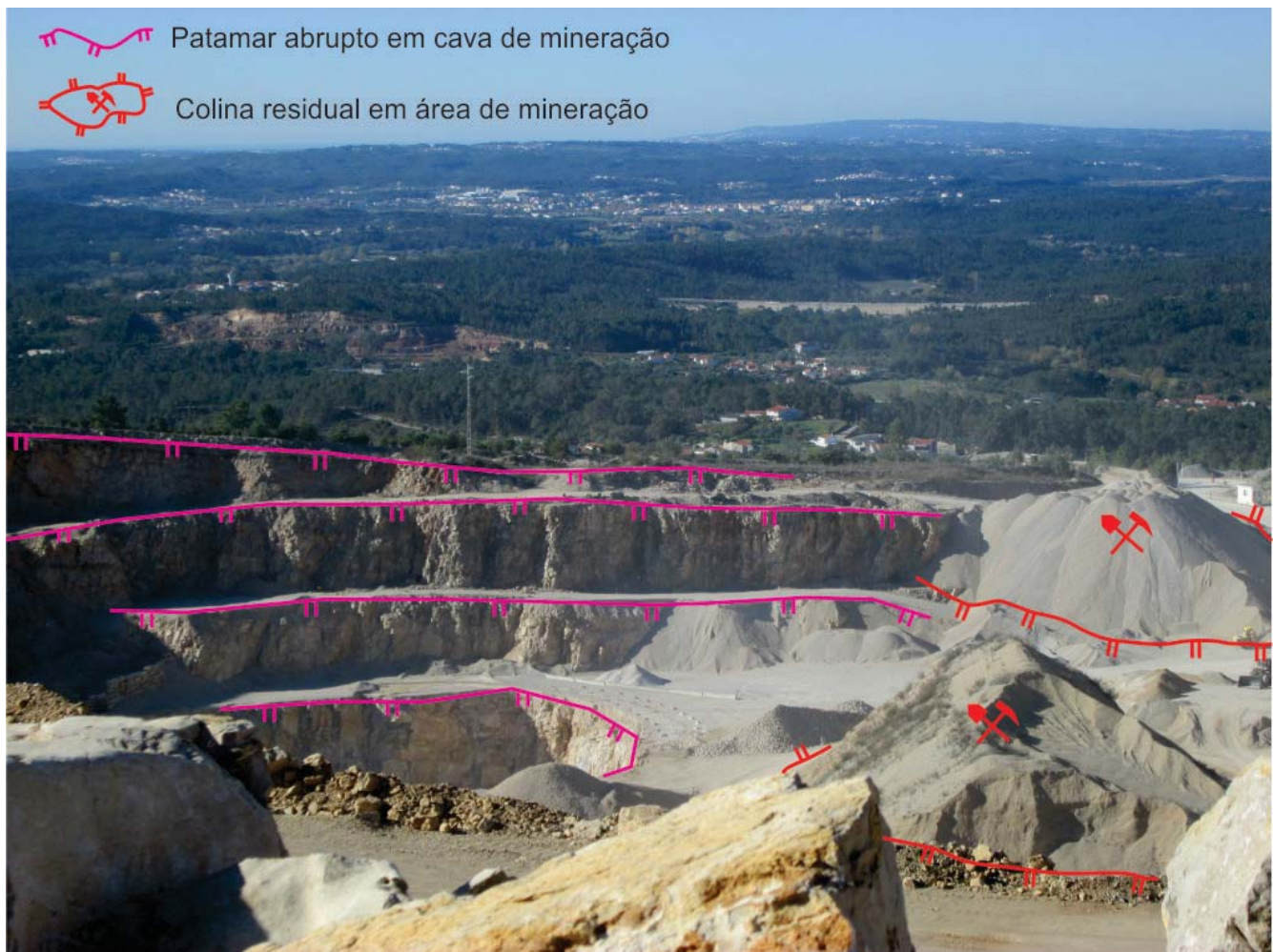
Figura 8 - Fotografia da área de mineração de calcário (Setor 2), que demonstra patamares em cava de mineração de característica abrupta e colinas residuais também de característica abrupta, com a simbologia representante de cada feição sobreposta, conforme consta na legenda da figura 6 e 7. Fonte: Paschoal, L. G. (2014).
