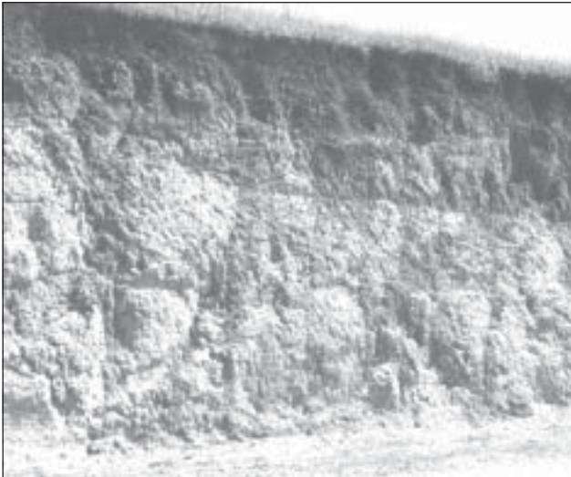
Foto 8: Horizonte caulínítico, apresentando diversas falhas.
