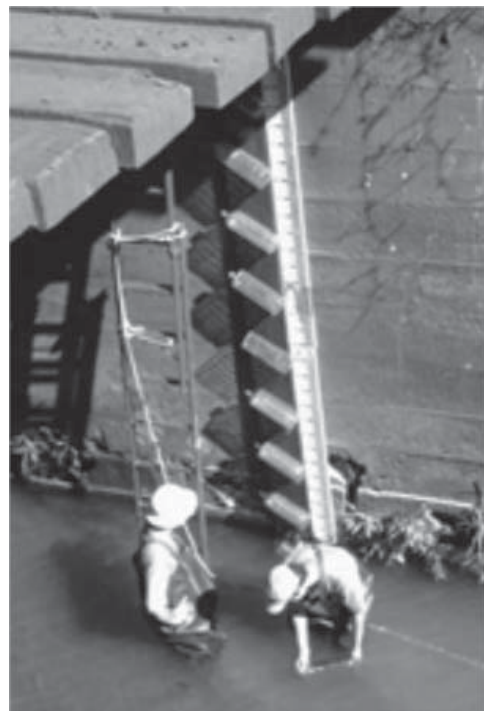
Figura 4 - Instalação da armadilha para coleta de sedimentos no ribeirão Mandacaru em uma seção tansversal fixa do rio.
