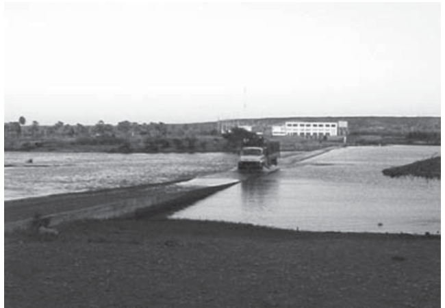
Figura 2 - Passagem molhada das Pedrinhas, tipo concretada com comporta lateral. Observar lâmina d'água passando por cima do barramento (período de estio). Set/ 1999. (Foto: Andrea Cavalcante)
