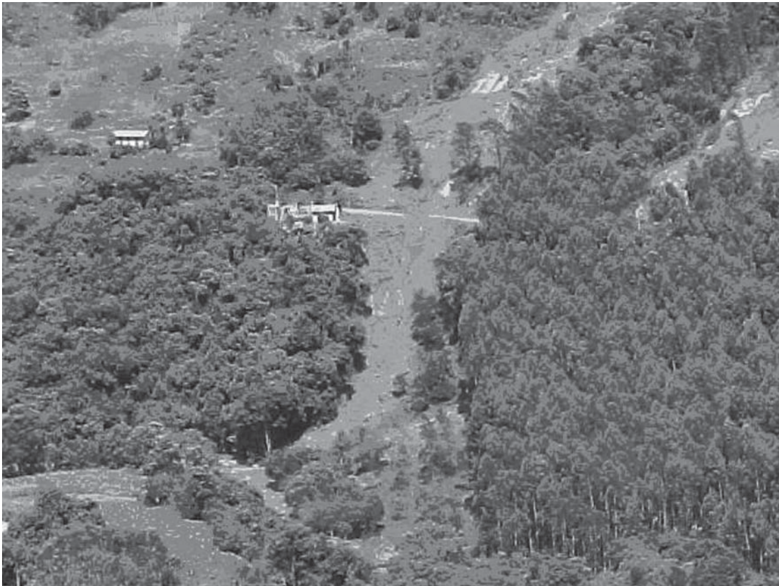
Figura 2 - Deslizamento de encosta de grandes proporções em Alto Feliz, próximo a RS 122.
