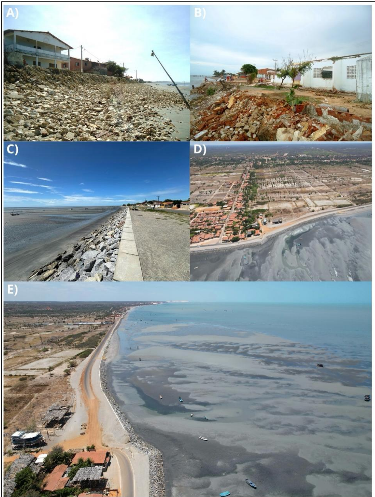
Figura 22. Evolução de um trecho da Linha de Costa no setor 3 analisada. A e B) Registros fotográficos do período de intensa atuação de processos erosivos e os consequentes danos às estruturas construídas no trecho em 2010; C, D e E) Registros fotográficos de 2024 obtidos no mesmo trecho.
