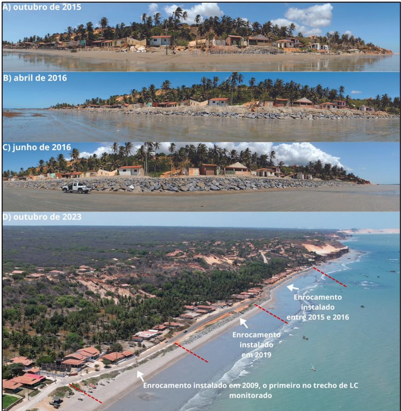
Figura 18. Evolução do processo de instalação de um enrocamento na Praia de Barreiras de Baixo entre os anos de 2015 e 2023. A) trecho da Praia de Barreiras de Baixo com o patrimônio edificado destruído em função de processos erosivos e recuo da Linha de Costa. Destaca-se a presença de estruturas paliativas para contenção da maré e da erosão no local; B) Início do processo de instalação do enrocamento para conter o recuo da Linha de Costa; C) Instalação do enrocamento finalizada e D) Panorama geral das estruturas rígidas construídas no setor em análise entre os anos de 2009 e 2019.
