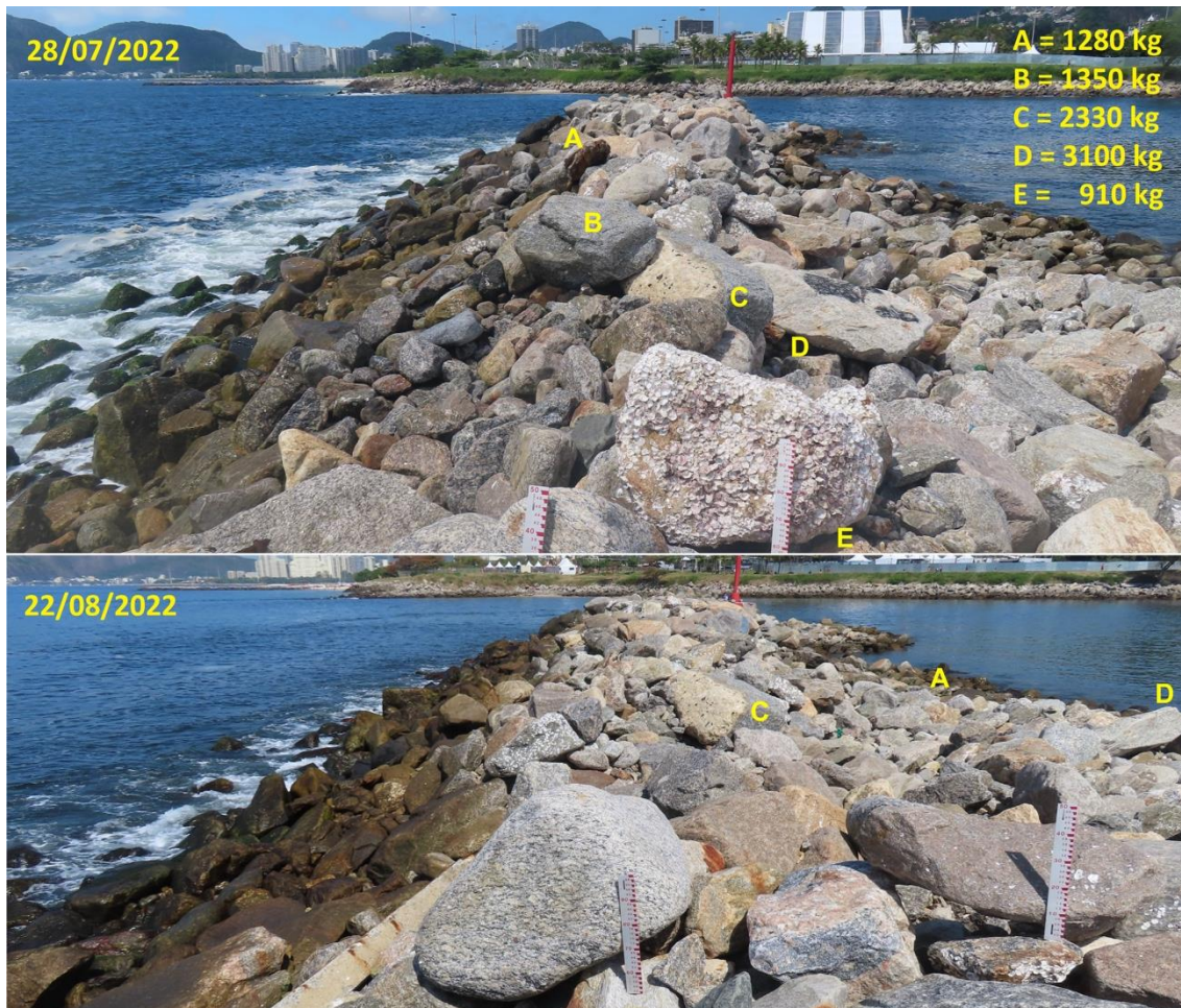
Figura 13. Quebra-mar da Marina da Glória. Situação em 28/07/2022, após grande movimentação dos clastos que ocorreu no dia 16/05/2022, ondas acima de 2 m transportaram matacões e blocos para o topo, a 3 m de altura. Situação em 22/08/2022. Quase todos os matacões e blocos foram transportados após outra tempestade ocorrida nos dias 11 e 12 de agosto. As escalas medem 50 cm. Fotos do autor.
