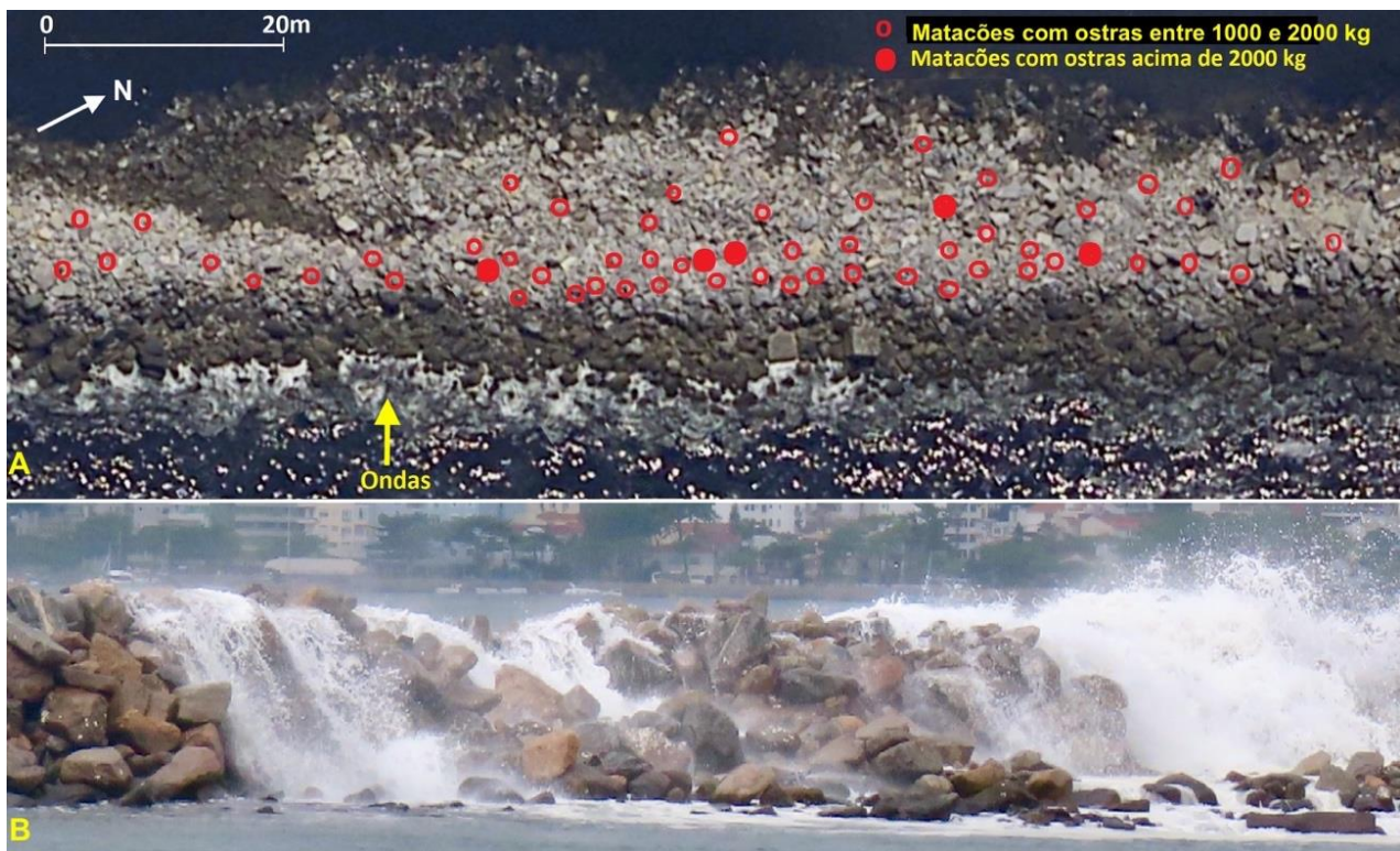
Figura 14. Avanço da crista do quebra-mar da Marina da Glória. A) Posição dos clastos com cracas e ostras em 01/10/2023. B) Fluxo de água arremessado por uma onda com altura acima de 2 m movimentando matações e blocos em 12/08/2022. A imagem do Google Earth serve apenas como base porque é anterior à data do mapeamento. Foto do autor.
