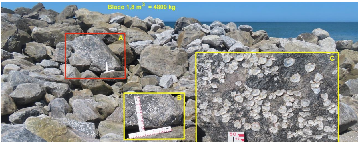
Figura 7. Bloco com volume aproximado de 1,8 m 3 com incrustação de ostras, pesando 4800 kg. Esse bloco foi depositado a 3 m de altura, depois de ter passado pela crista do enrocamento, com altura entre 4 e 5 m. Praia de Itaúna (RJ). As régua medem 50 cm. Fotos do autor.
