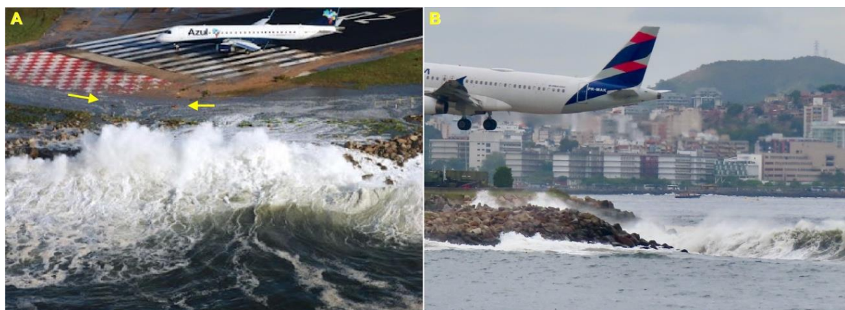
Figura 15. A) Ressaca no dia 8 de abril de 2010 com ondas acima de 3 m de altura na cabeceira sul do Aeroporto Santos Dumont. As setas indicam as posições de alguns matações grandes que foram transportados por até 60 m. Matações pequenos e calhaus foram depositados a 200 m de distância. Cada quadrado vermelho ou branco na pista mede 2 m de lado. B) Situação em 29/09/2023, com ondas menores que 3 m de altura em período de maré baixa de sizígia. Fotos de Roberto Fantinel (UOLFoto) e do autor.
