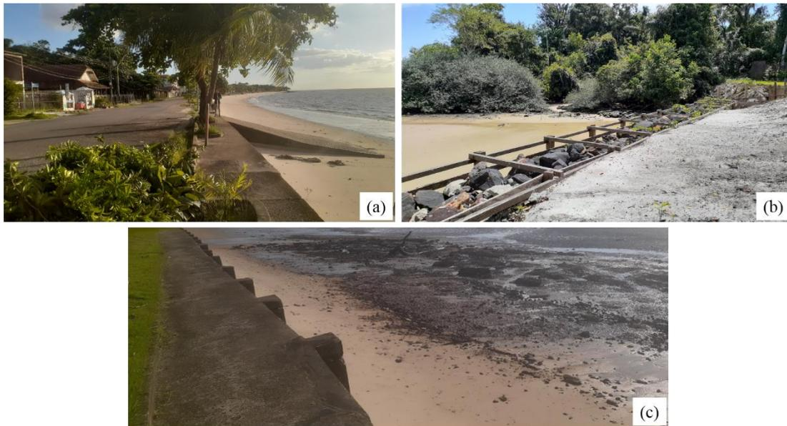
Figura 5. Calçadão da praia do Murubira (setor noroeste) (a). Enrocamento na praia do Paraíso (setor norte) (b). Muro de contenção de erosão na praia Grande (setor oeste) (c).
