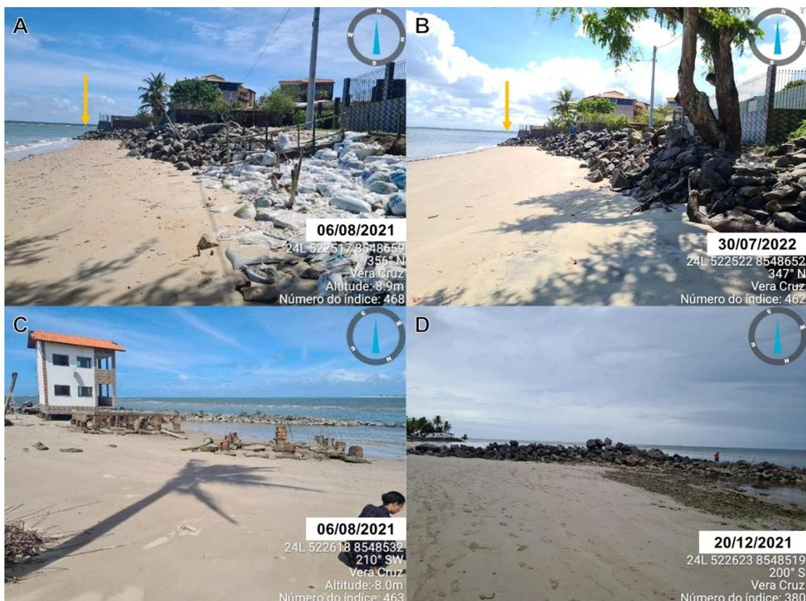
**Figura 11.** Estruturas de contenção (enrocamento de rochas e sacos de areia) e edificação irregular na parte estuarina de Cacha Pregos. As fotos (A) e (B) foram obtidas no ponto CP-22, em agosto 2021 e dezembro de 2021, respectivamente. As fotos (C) e (D), de agosto de 2021 e dezembro de 2021, respectivamente, registram o ponto CP-21.
