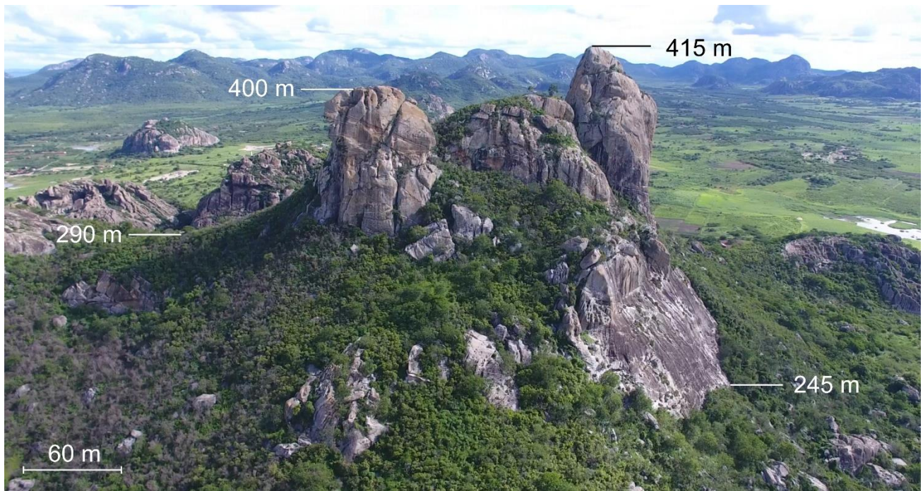
Figura 3. Pedra da Galinha Choca, composta predominantemente de feições associadas ao fraturamento: escarpas íngremes com morfologia angulosa e ampla rampa de tálus. Os dados de altitude indicados na figura foram extraídos no modelo digital de elevação da PGC obtido com aerofotogrametria. Fonte: Elaborado pelos autores.
