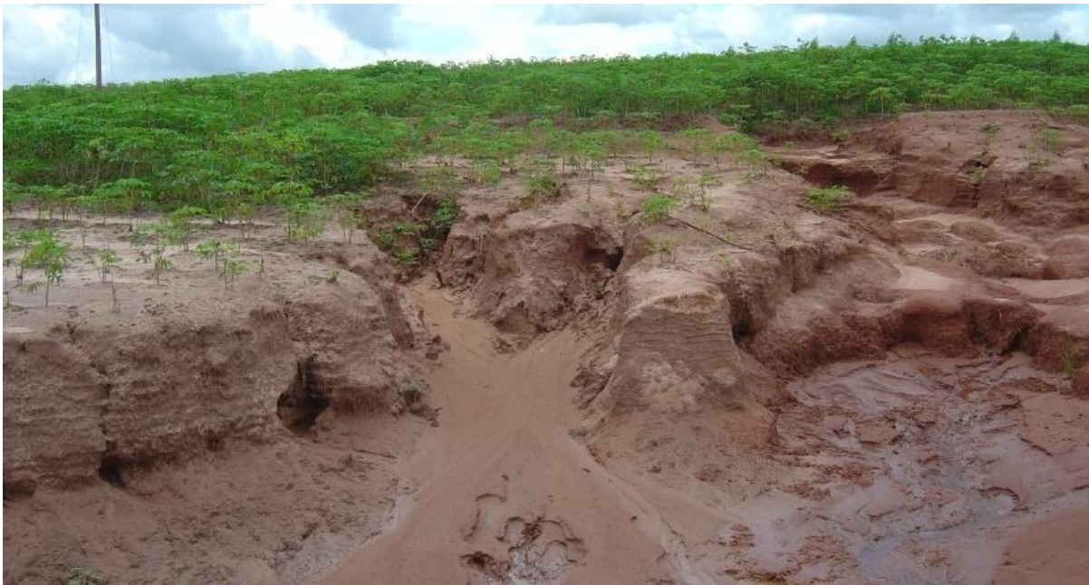
Figura 14. Ocorrência de piping no segmento superior da voçoroca de Tamboara, evidenciado pelos dutos expostos nos taludes
