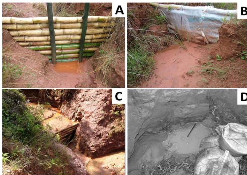
**Figura 5.** Barreiras de retenção de sedimentos: (A) Barreira estruturada em hastes de bambu; (B) fixação de sacos de rafia; (C) Barreira de eucalipto com retenção de sedimentos; (D) Barreira de solo ensacado. Fonte: Adaptado de Silva (2010); Serato e Rodrigues (2010) e Pereira Junior (2013).
