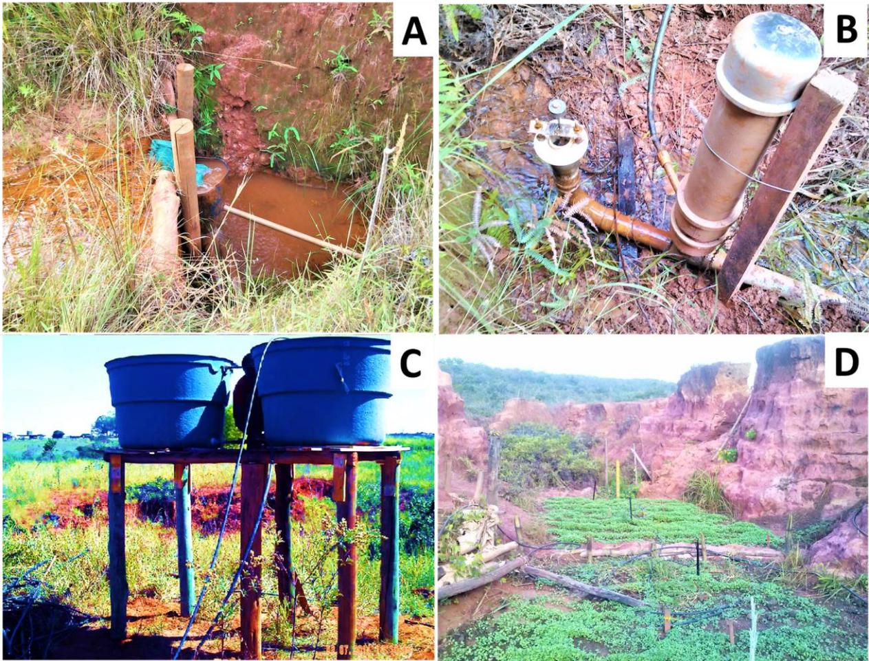
**Figura 13.** Captação de Água Canal Principal Voçoroca (A); Carneiro Hidráulico (B); Sistema de Armazenamento e Distribuição de Água (C); Fase Inicial de Irrigação (D). Fonte: Confessor, Machado e Rodrigues, 2016.
