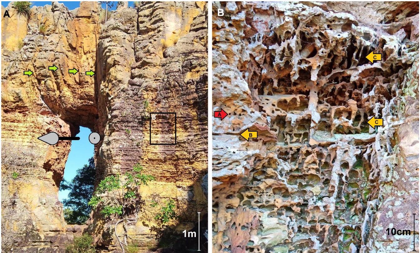
Figura 4. Carstificação da Formação Cabeças - PI. Foto A: Galeria vertical aberta entre fraturas verticais (Setas verdes). Setas frontais indicam a orientação NW-SE e E-W. Foto B: Formas dos vugs e alvéolos. Seta vermelha A indica vugs circulares do estágio inicial. A seta amarela B indica a coalescência de vugs no plano da camada gerando um nível de dissolução horizontal. As setas amarelas C indicam vugs alongados na vertical, formados pela carstificação em planos de fraturas em camadas delgadas.
