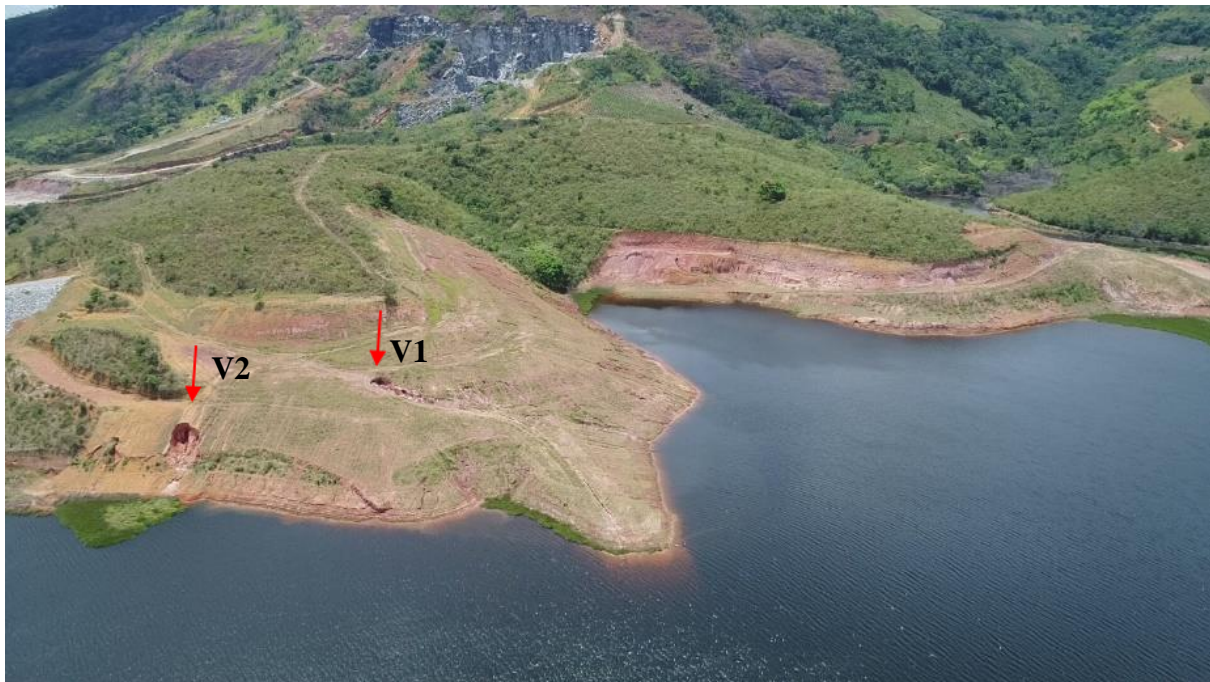
Figura 10. Margem direita do reservatório e a indicação (seta vermelha) das voçorocas 1 (V1) e 2 (V2). Fonte: autores (dez/2017).
