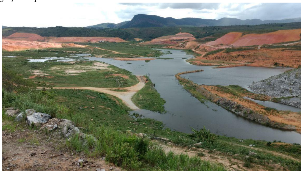
Figura 5. Finalização das obras na área do futuro reservatório da barragem Serro Azul. Fonte: Pedro Cavalcanti (fev. 2017).
