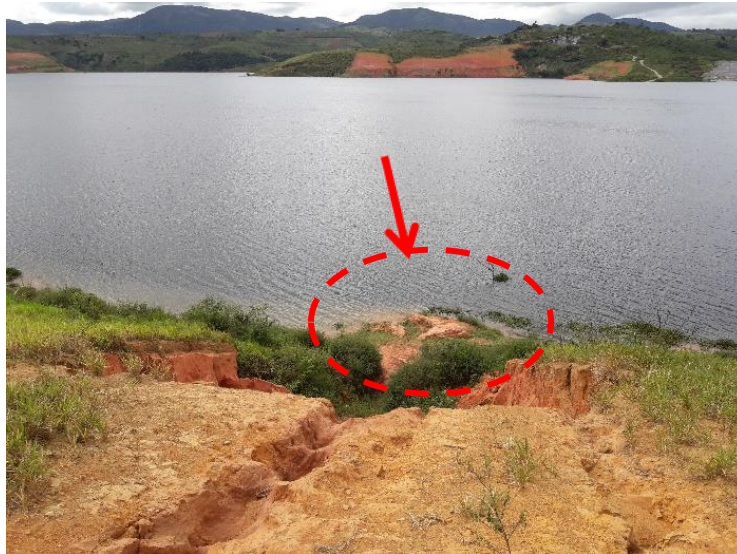
Figura 13. Deposição dos sedimentos oriundos da voçoroca, contribuindo para o assoreamento do reservatório da barragem Serro Azul. Fonte: trabalho de campo (ago. 2018).
