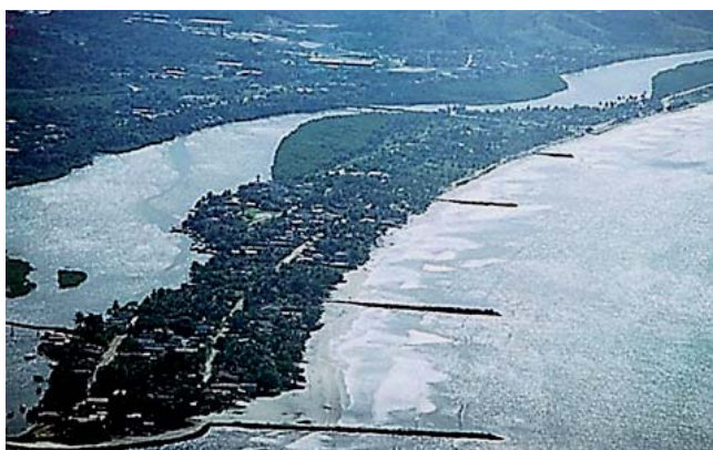
Figura 9 – Conjunto de espigões instalados em 1998 ao longo da praia de São Miguel, com o objetivo de conter o avanço do processo erosivo.
