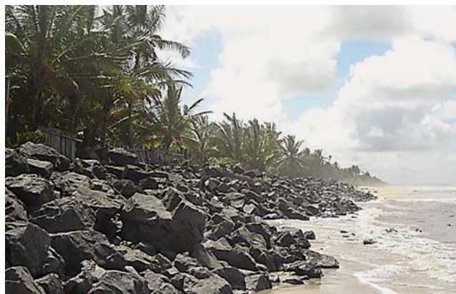
Figura 10 – Enrocamento protegendo residências da ação erosiva das ondas na praia de São Domingos.
