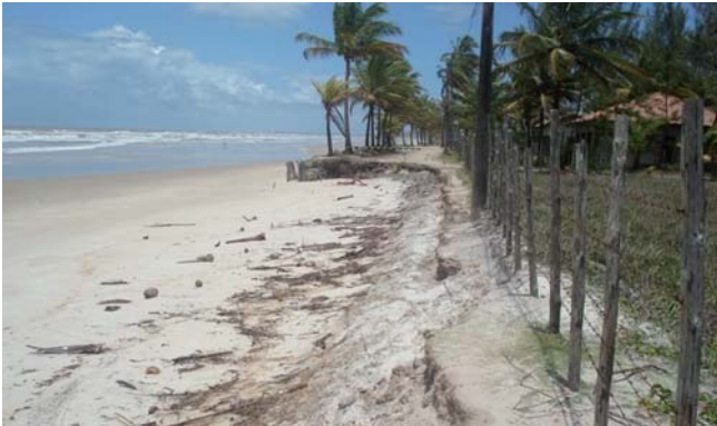
Figura 4 – Destruição da estrada à beira-mar na praia da Costa, em Canavieiras.
