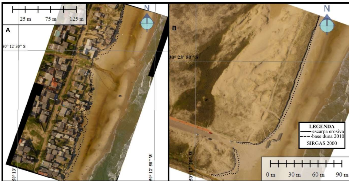
Figura 18 - Escarpa erosiva e antiga base da duna frontal dos balneários Zona A (esquerda - A) e Dunas Altas (direita - B).
