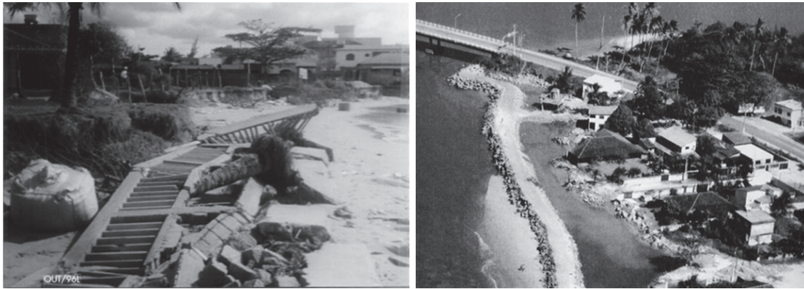
Figura 8 - Erosão em Praia Grande com destruição das residências próximo à praia (outubro, 1996). Obra realizada em 1997 na extremidade sul da Praia Grande para conter o processo erosivo (Fotos: Luiz Viana).
