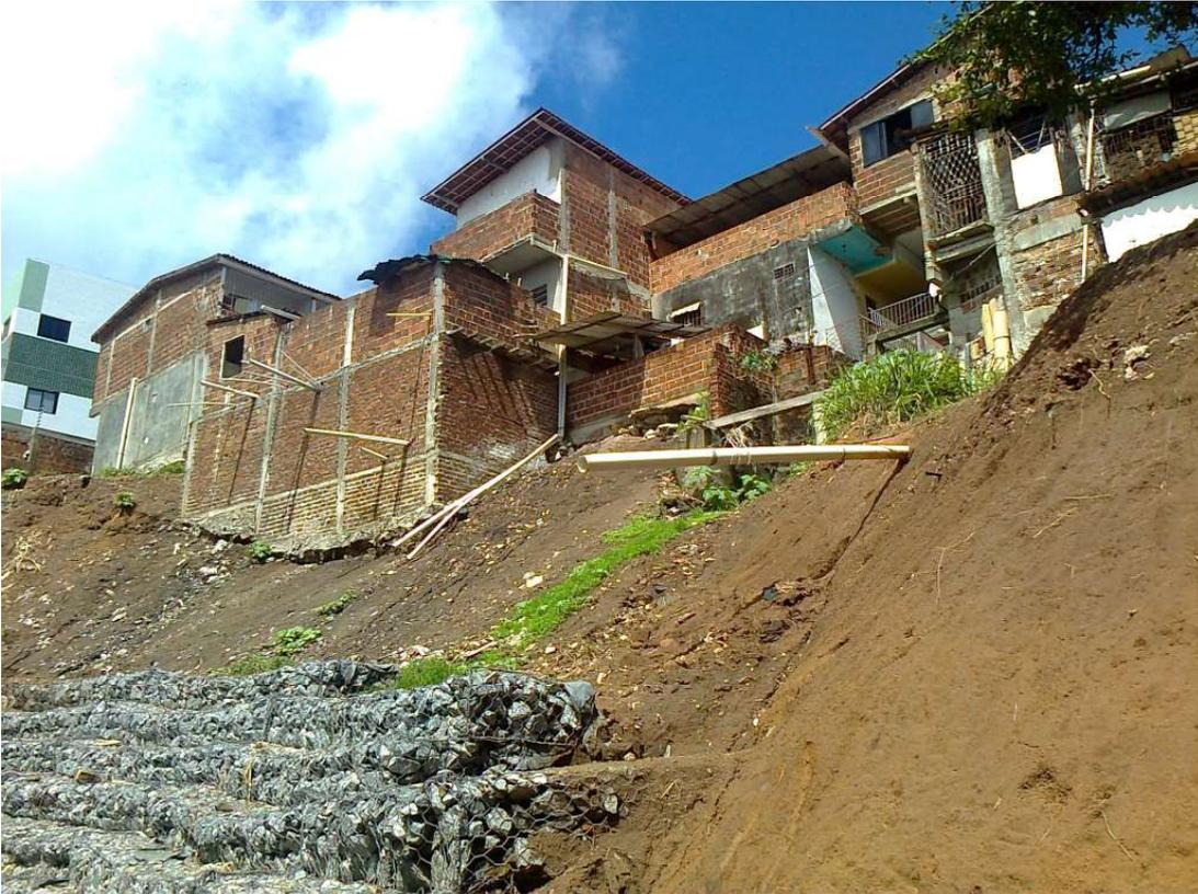
Figura 6 - Moradias construídas no topo de vertentes na Formação Barreiras lançando águas servidas sobre o talude na Comunidade Santa Clara, bairro do Castelo Branco. Fonte: Acervo fotográfico da Coordenadoria Municipal de Proteção e Defesa Civil / COMPDEC – JP (2014).
