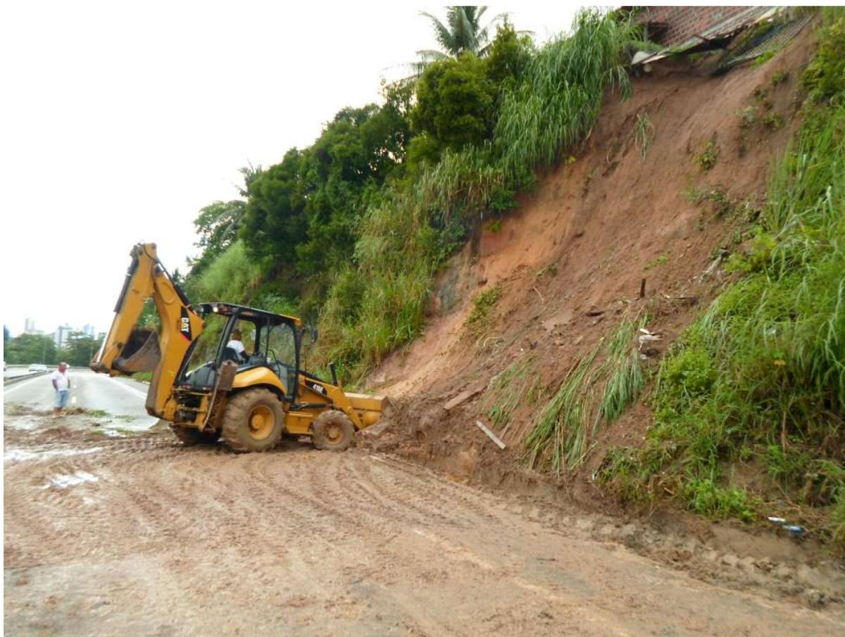
*Figura 5 – Deslizamento na Formação Barreiras em vertente de corte de estrada na BR 230, bairro do Castelo Branco.*
