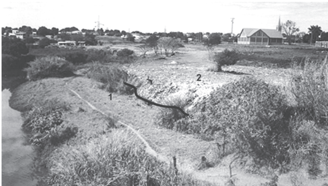
Figura 8 - DT induzido (1) sobreposto por DT construído (2), margem direita do ribeirão Anicuns sobre o qual foi aberta uma trincheira para colocação da tubulação para captação de esgotos. Área de pesquisa de CUNHA (2000).
