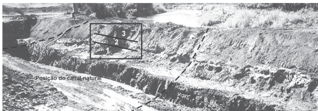
Figura 9 - F 47 vista geral das obras de desvio do canal atual do rio Meia Ponte: 1 – embasamento, 2 – depósito residual de canal/tecnogênico induzido, 3 – tecnogênico construído.
