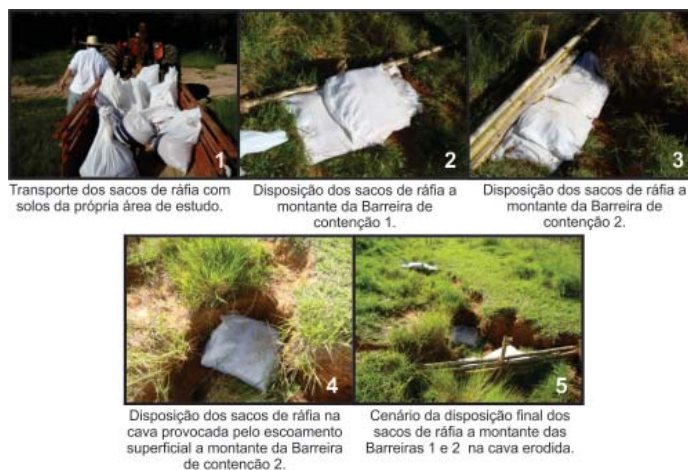
Figura 5 – Etapa de disposição dos sacos com solos para reduzir a velocidade do escoamento da água. Foto: Dos autores, trabalho de campo, abril de 2012.
