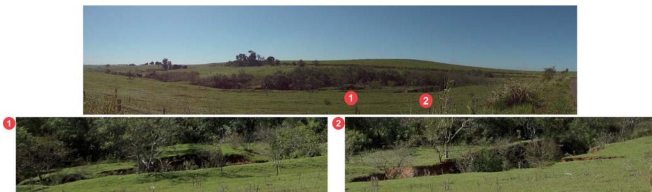
Figura 12 – Processos de voçorocamento nas médias-baixas vertentes (alta vulnerabilidade). Foto: Dos autores, trabalho de campo, janeiro de 2012.
